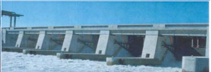
**Kraftwerk Ybbs-Persenbeug:** Das Laufwasserkraftwerk erzeugt im Jahr durchschnittlich 1.335,9 Mio. kWh bei einer maximalen Leistung von 236.500 kW.
